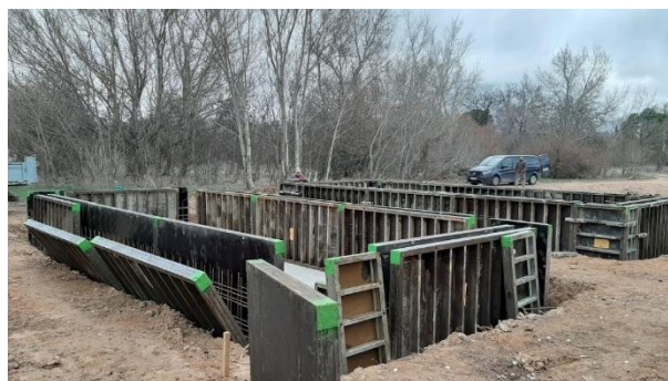
Figura 1. Encofrado de los muros de los canales
